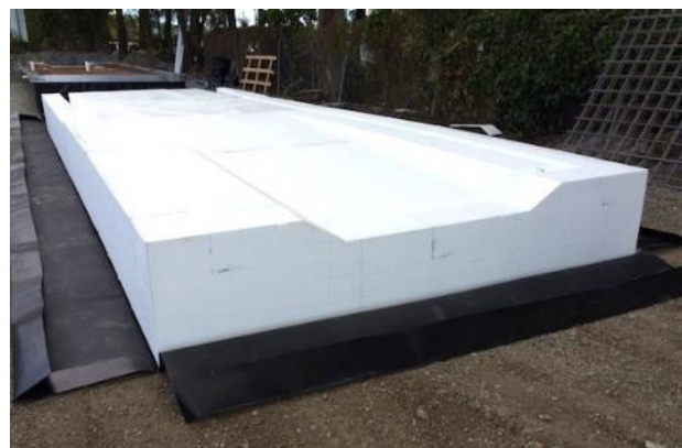
Pilt 12 Pontooni sisemus. Polüstüreenvaht (valge), polüetüleen vooder (must). Allikas: Aqua Pontoons 1300 s.a.
