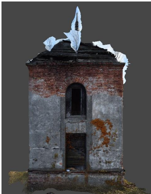
21. Agisoft Metashape Standard fotogrammeetria 3D mudel. Objekti hetkeolukord.
